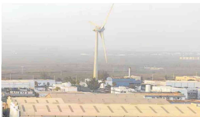
Vista aérea de la central de producción Diaz Rijo, que acoge la presencia de tres desaladoras. COBER LANZAROTE
