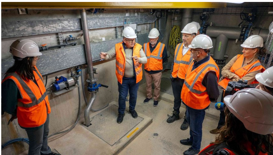
Présentation du nouveau système de recyclage à l'usine de potabilisation de Sète.
